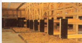
Näseby Gardi lauta Soomes. Puidust latripäärdeid on metalloosadega tugevdatud. Latriridade vahel on näha vasikatele mõeldud ruum.
